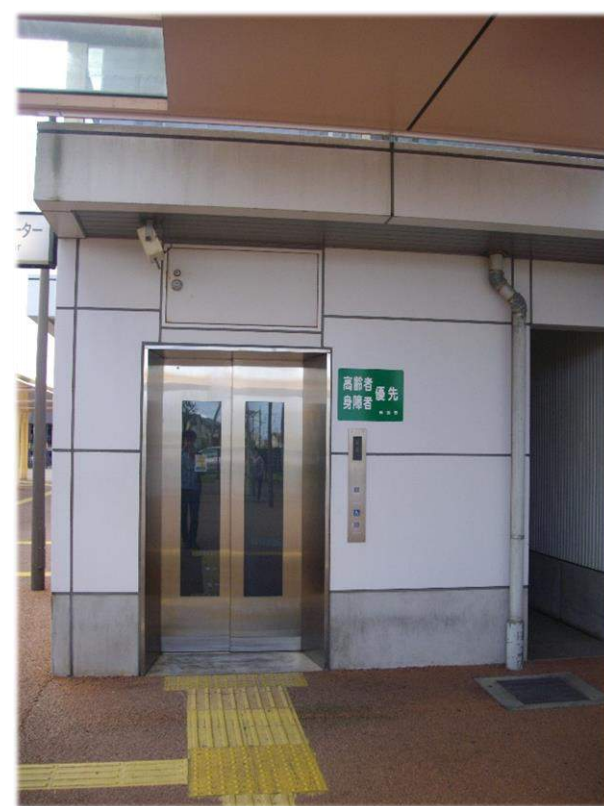
エレベーター
